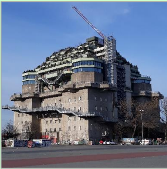
Hochbunker St. Pauli
